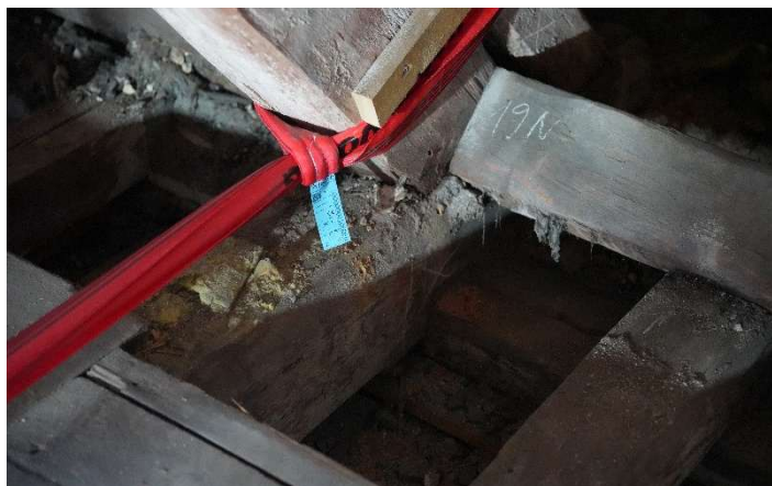
Bild: Balken und Dachsicherung innen.
